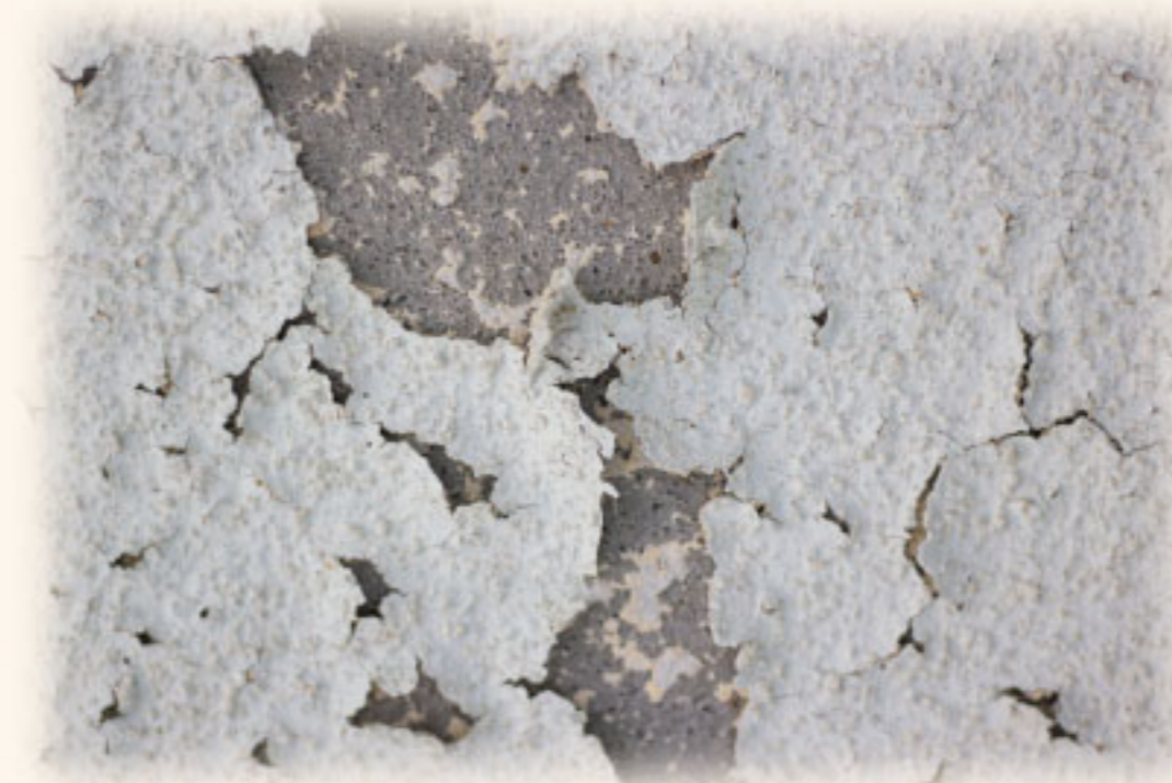
塗装の剥がれ、外壁のひび割れ
