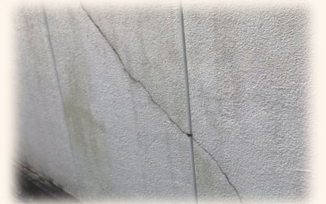
塗装の剥がれ、外壁のひび割れ
